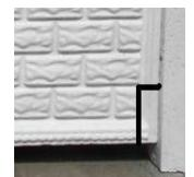
**Tipp:** bei Gelände mit Gefälle, müssen Sie die Pfosten in Stufen einbauen und die untersten Betonplatten der gewünschten Abstufung anpassen (Ecken werden ausgeschnitten - s. Bild.
